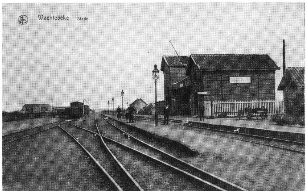
Het stationsgebouw, zicht richting Moerbeke-Waas, links in de verte het "cementfabriekje".
