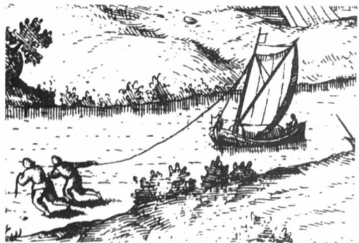
Sloopstrekkers aan het werk 156
