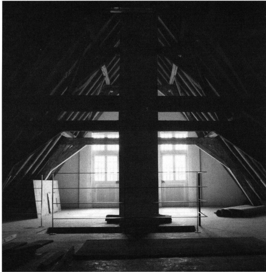
De vernieuwde gebinten en de nieuwe plankenvloer op de zolder.
