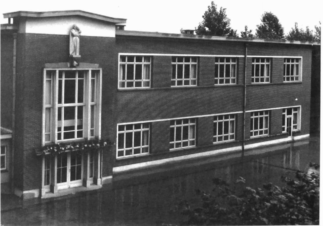
17. Het vierde pensionaatgebouw van 1955-1956 naar plannen van architect Albert Lefebure van Zelzate (verhoogd met twee verdiepingen voor het internaat in 1963).
