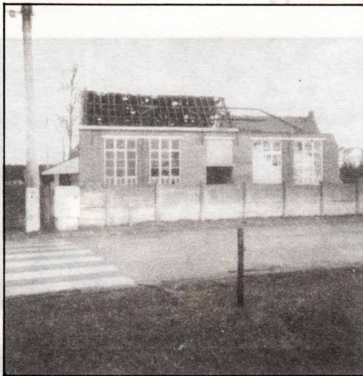
FOTO: DE SLOPINGSWERKEN AAN DE SCHOOL ZIJN AL VER GEVORDERD.
