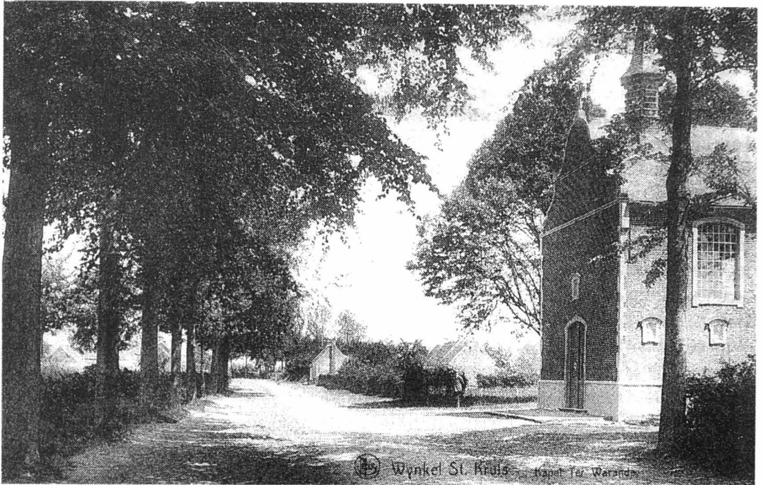
Foto 27: Kapel van O.-L.-Vrouw van Troost ter Warande rond 1920. Het oorspronkelijke kapelletje werd reeds rond 1200 opgericht, en dit vermoedelijk als dank voor een bekomen gunst.
