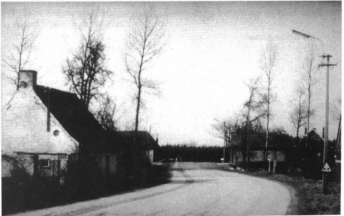
Foto 75: Ondanks de Gentse plannen om de rechterkanaaloever tot industrieterrein om te vormen, besloot het Winkelse gemeentebestuur begin de jaren vijftig de Rostijnestraat en de Nonnenstraat van een betonnen wegdek te voorzien. Hier zien we de Rostijnestraat richting Zelzate, met links het huisje van Kamiel De Wever en Emma De Soomer, en achteraan de oude herberg "Halfweg". Rechts zien we het boswachtershuis van de familie De Wulf.
