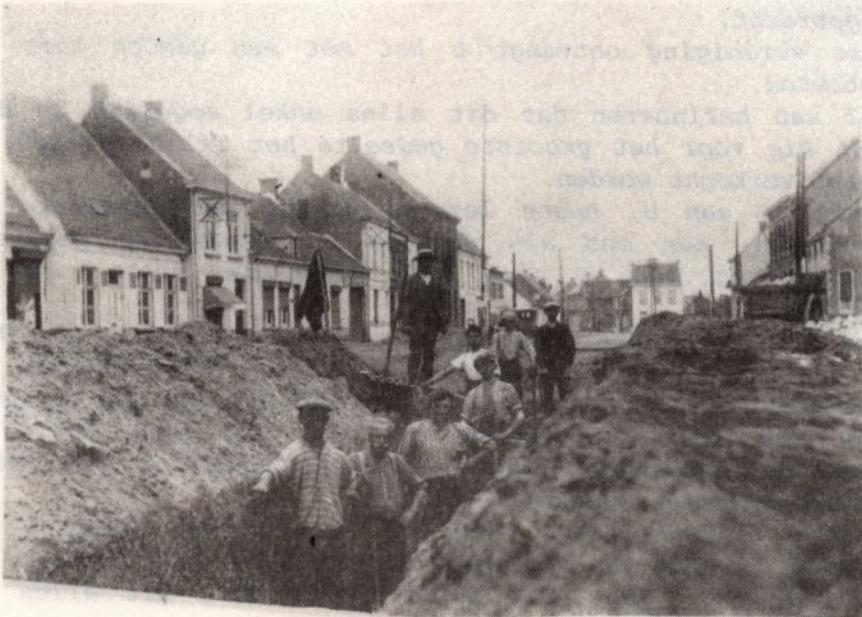
Foto : Rioleringswerken in 't dorp uitgevoerd door de firma VAN MOSSEVELDE.
