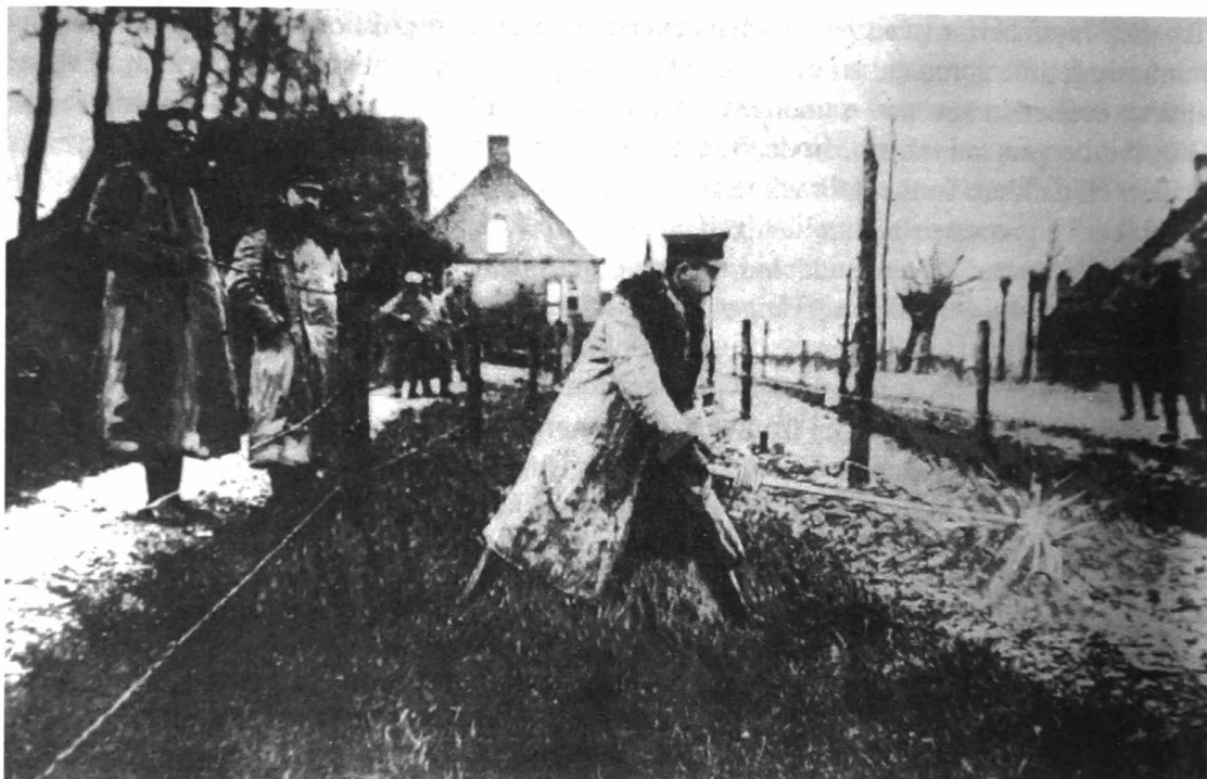
Een officier test de versperring met een geïsoleerde staaf (Weltspionage, 1931: 447)
