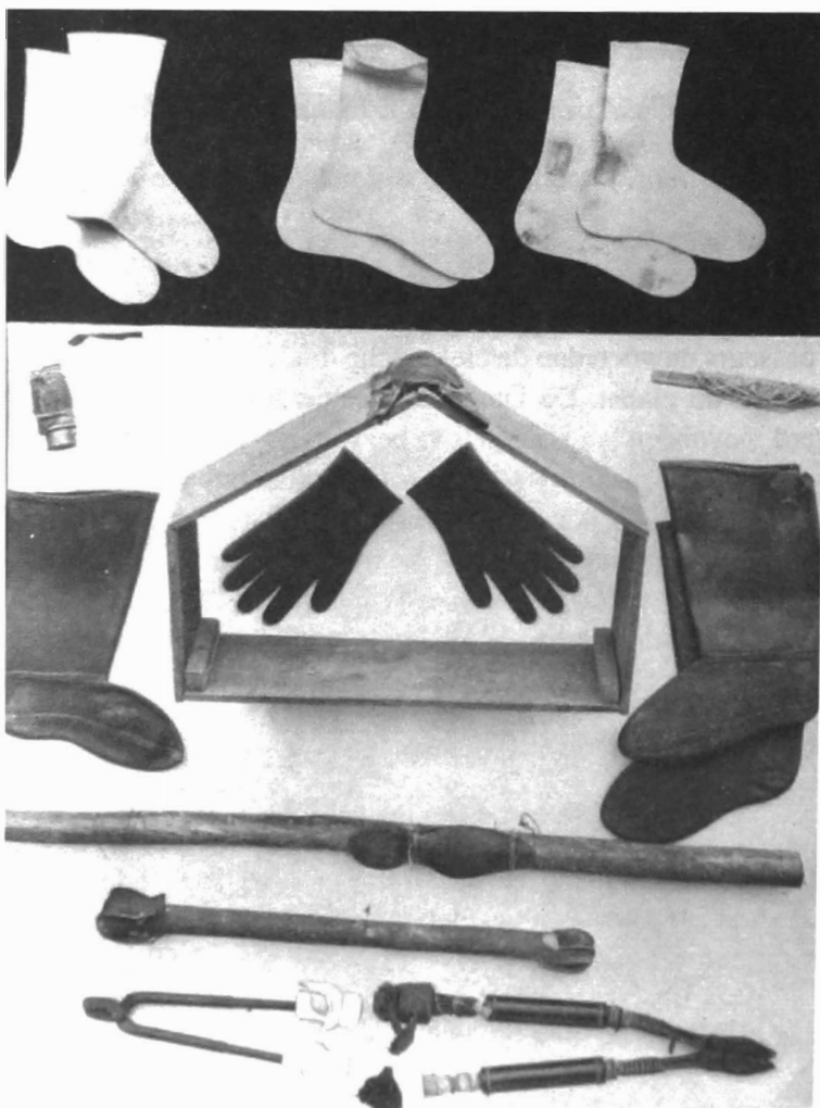
44. Het instrumentarium van de passeurs. Bovenaan: isolerende (gummi) sokken om over de schoenen te trekken. In het midden, links en rechts: gummi laarzen, eveneens om over de schoenen te trekken. Tussen de laarzen: een primitief passeursraam. In het raam liggen gummi handschoenen. Onderaan rechts: de grote Engelse kniptang, en net erboven een aan twee kanten geïsoleerde stok om de versperringsdraden uiteen te duwen (FOERSTER, 1931: Tafel L)
