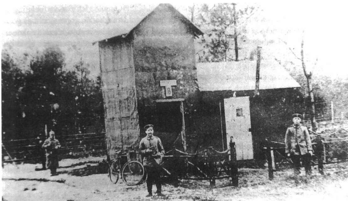
Schalthaus en soldatenverblijf aan de versperring; let op de klaarstaande fiets (SPAPEN, 26)
