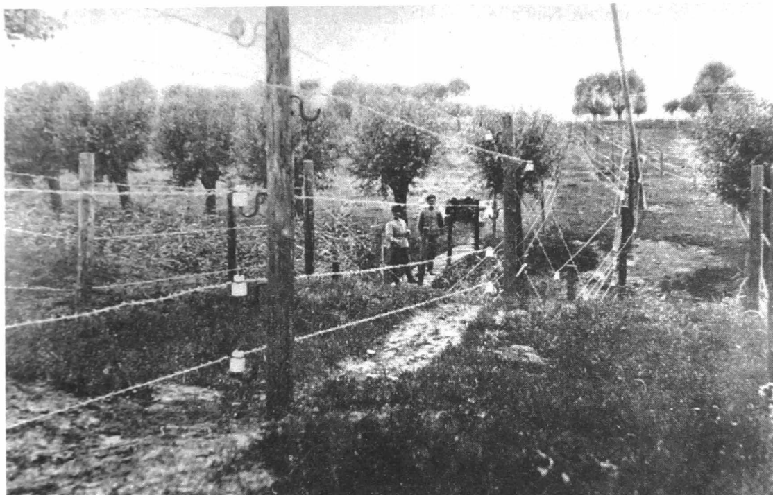
De draadversperring op het platteland. Wij zien hier duidelijk een centrale draadversperring met 5 boven elkaar liggende prikkeldraden, en links en rechts van de middenste versperring telkens nog een lagere afsluiting met minstens een drietal draden. Men onderscheidt duidelijk de porseleinen isolatoren (BRUGMANS, s.d.: 225)
