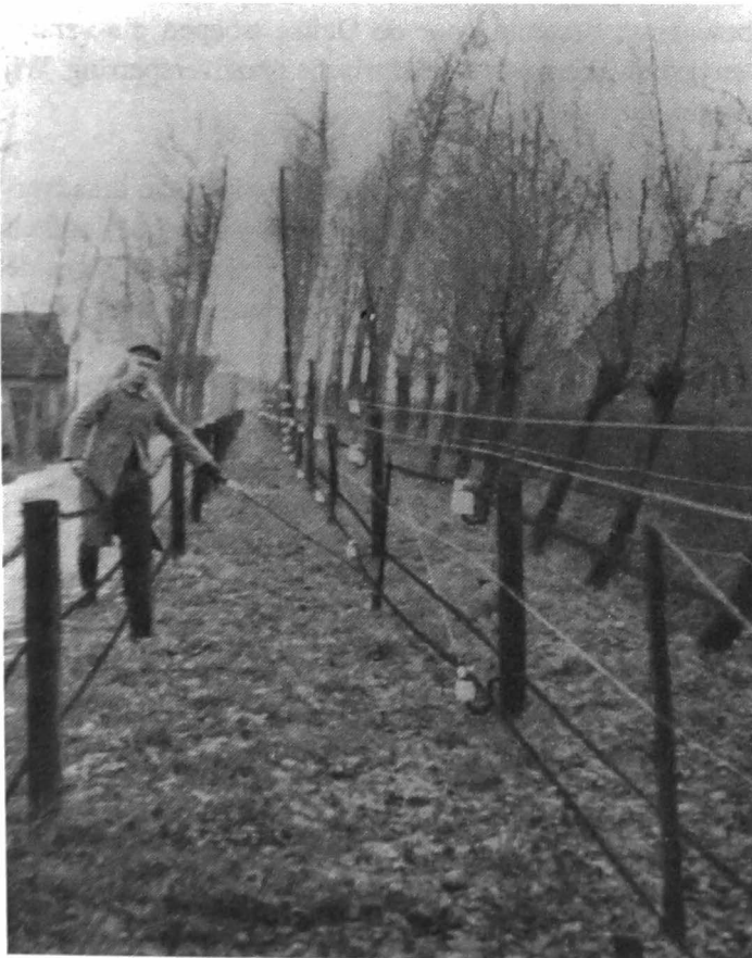
Een verantwoordelijk technicus test de spanning op de versperring (FOERSTER, 1931: Tafel M)
