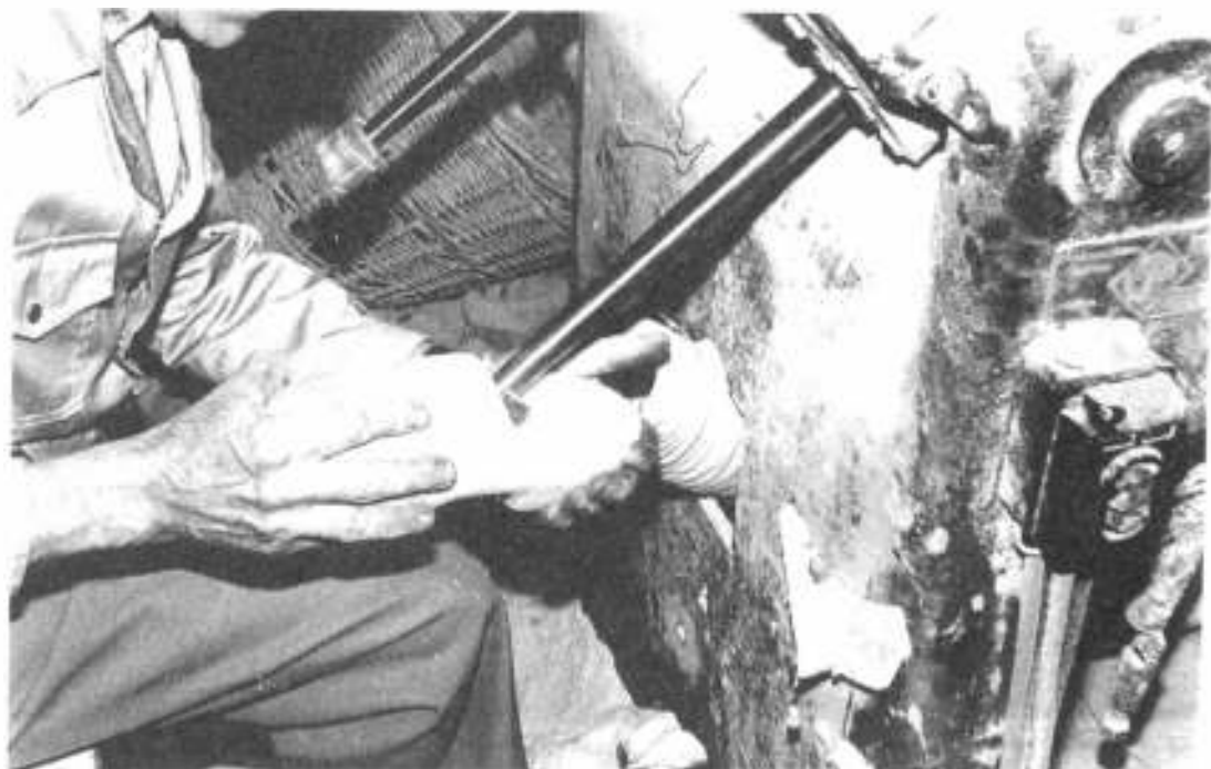
Fig. IX 46 : Inwendig uitschuren van de klompen.
